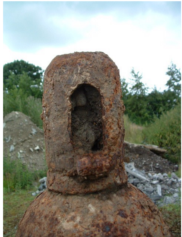
Exemple de bouteille extrêmement corrodée contenant un gaz haute pression.
